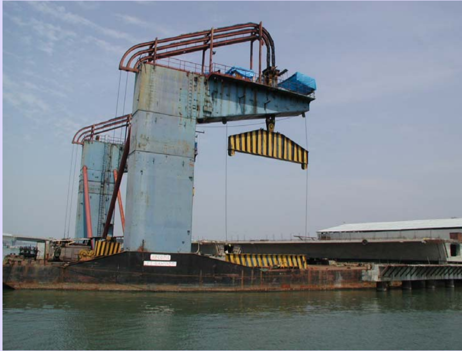
(d) Transporting of box girder
